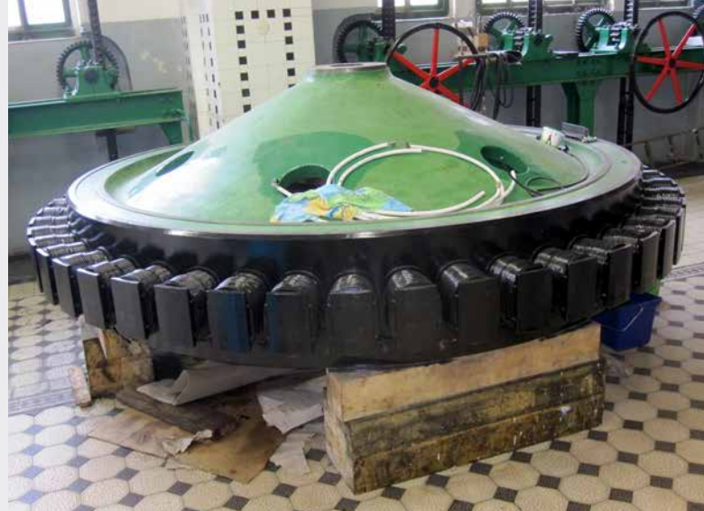
▲ Rotor generátoru po demontáži a opravě
