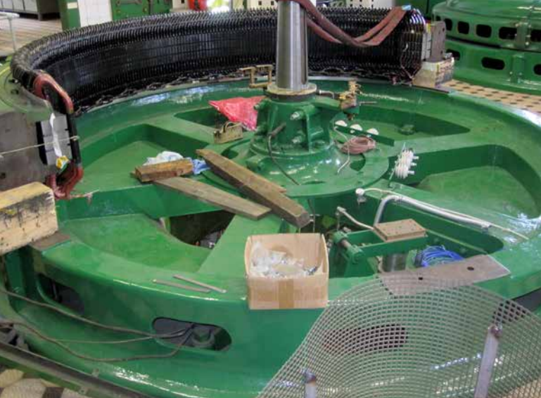
▲ Zpětná montáž statoru generátoru
